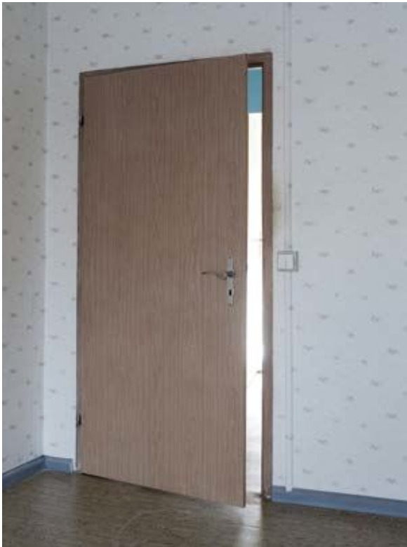
vor der Sanierung
